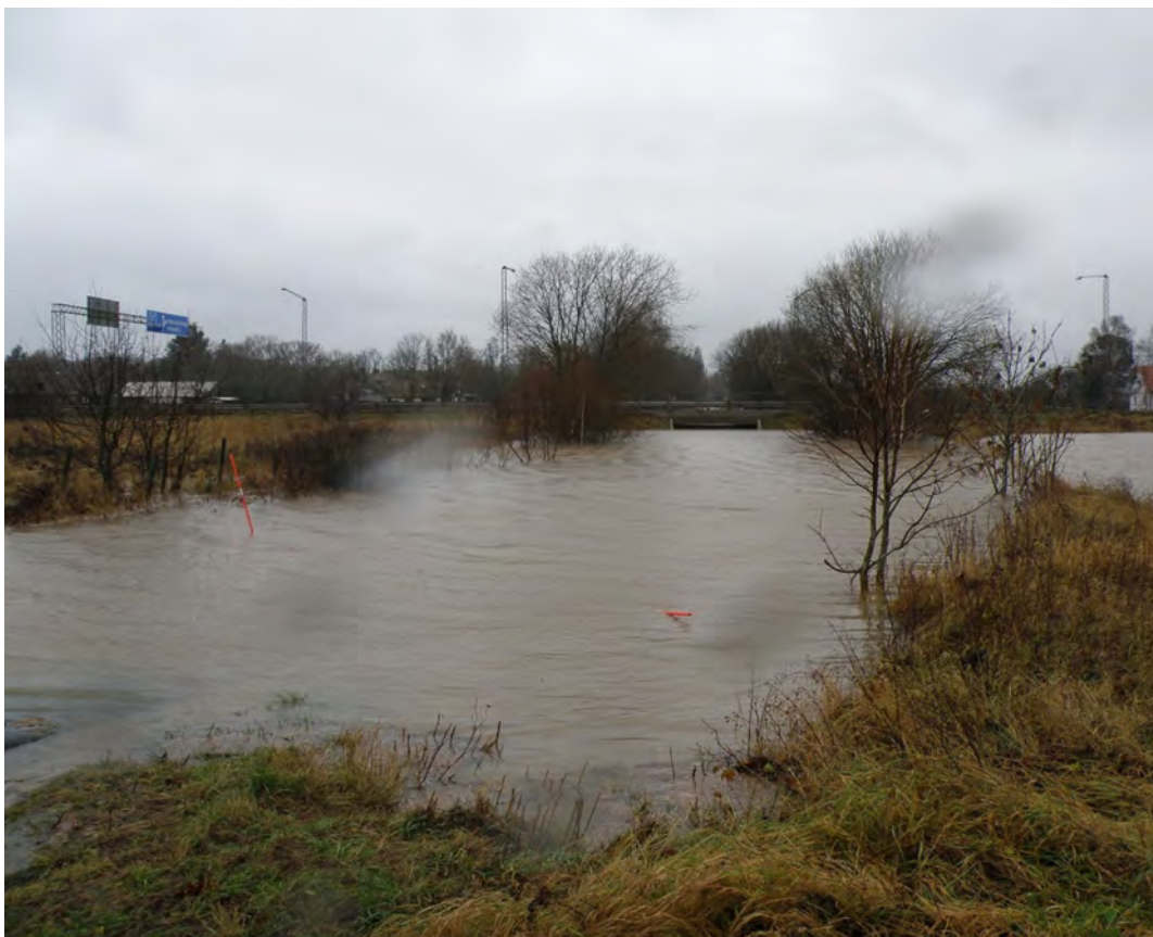
Tunnel vid Möllstorgsgatan under länsväg 137 vid översvämning 2010. Foto: Mörbylånga kommun.
