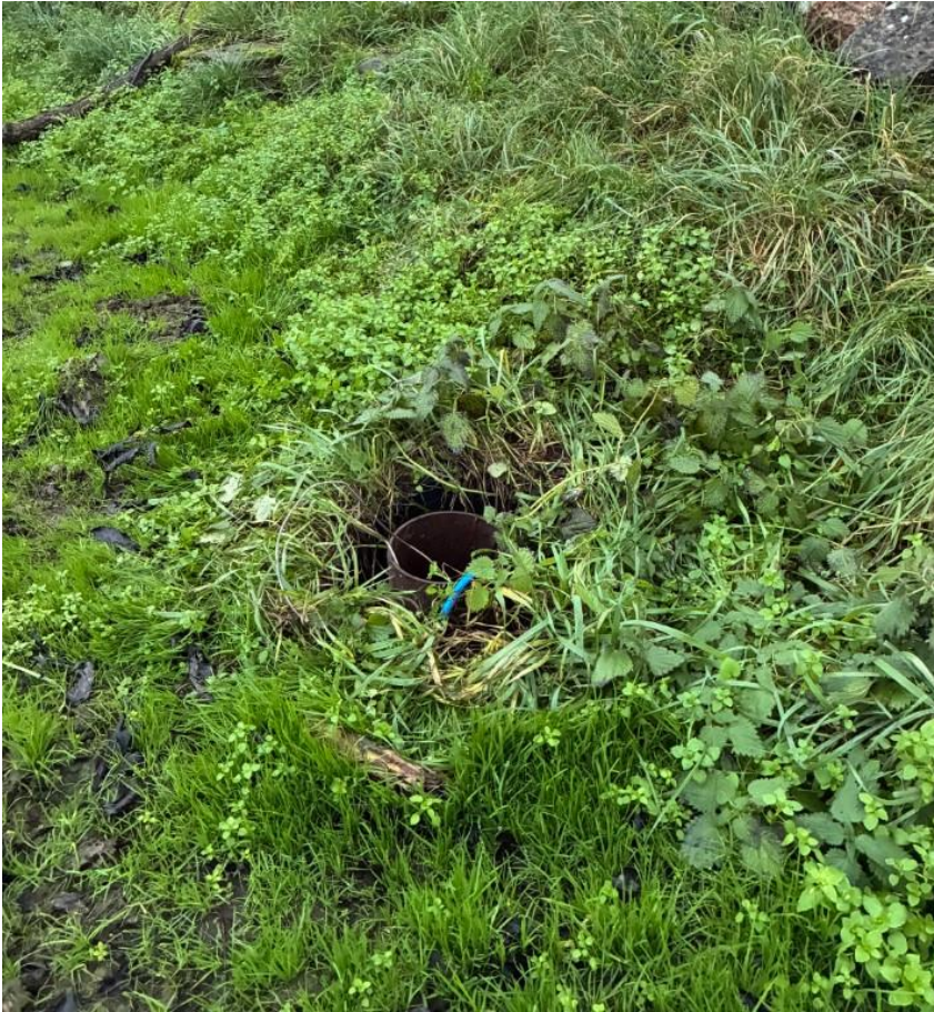
Figur 22. Översiktsbild på borrarbrunn 109 vars överkant är belägen 2 cm över markytan, utan lock.
