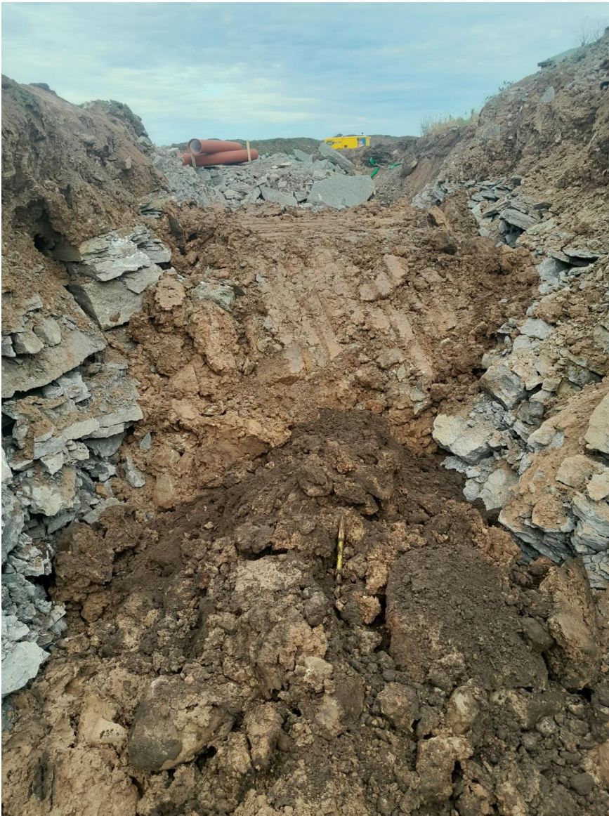
Figur 11. Strömningsavskärande fyllning med befintliga massor bestående av lera och silt inuti ett bergschakt. Fotot visar även de horisontella sprickorna i kalkberget längs sidorna på bergschaktet.
