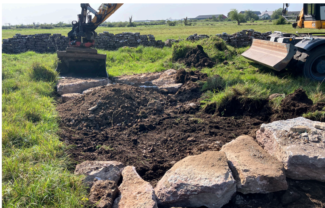
Igenläggning av dike för restaurering av 5 hektar våtmark. Foto: Michael Ingard.
