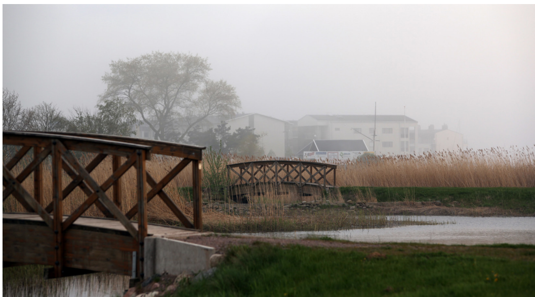
Dagvattendammar i Färjestadens dämme. Anlagda i två etapper 2006 och 2015 med syfte att rena stora volymer dagvatten innan det når Kalmarsund. Foto: Michael Ingard
