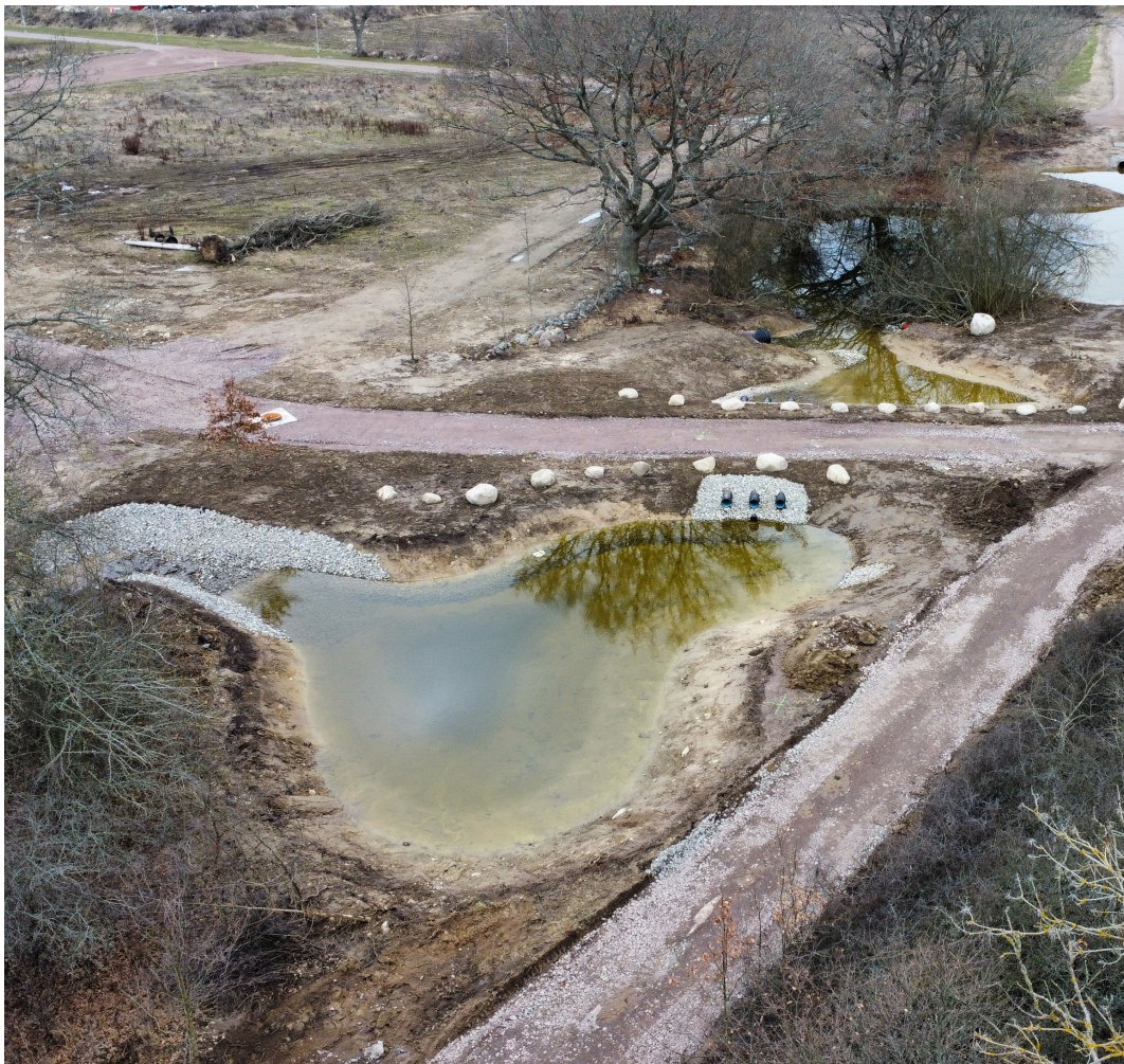
Nyanlagd multifunktionell dagvattenanläggning vid industriområdet i Färjestaden 2026. Foto: Michael Ingard.
