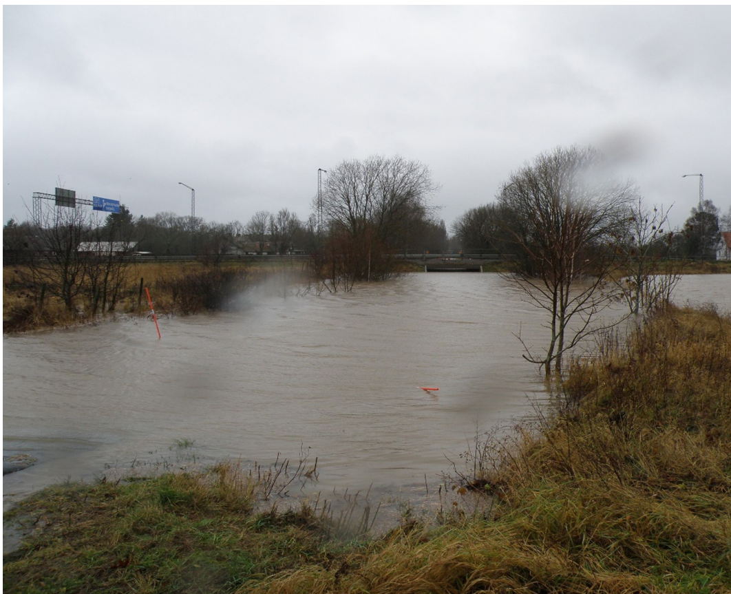
Tunnel vid Möllstorpsgatan under länsväg 137 vid översvämmning 2010. Foto: Mörbylånga kommun.
