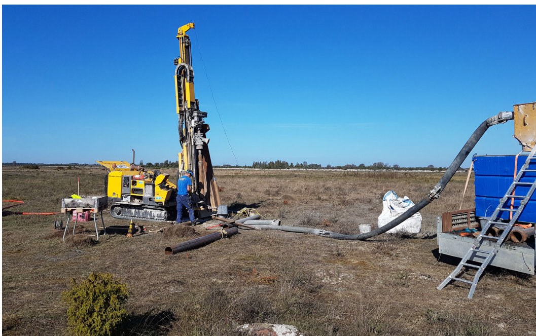
Borrning efter vatten under vattenkrisen 2016. Foto: Michael Ingard
