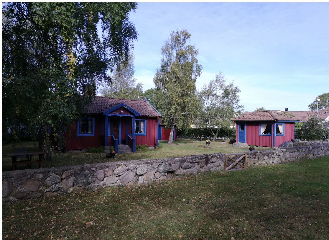
Omgivande bebyggelse består av småskalig och tät villabebyggelse.
